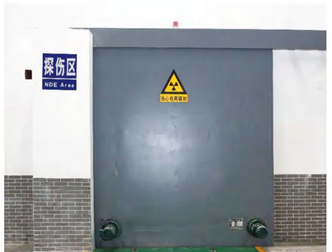
大型射线探伤室
