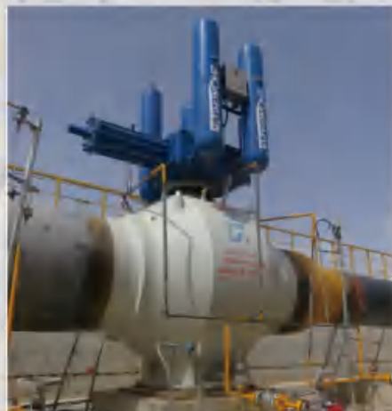
56"-900LB四阀座全焊接球阀工业性应用
