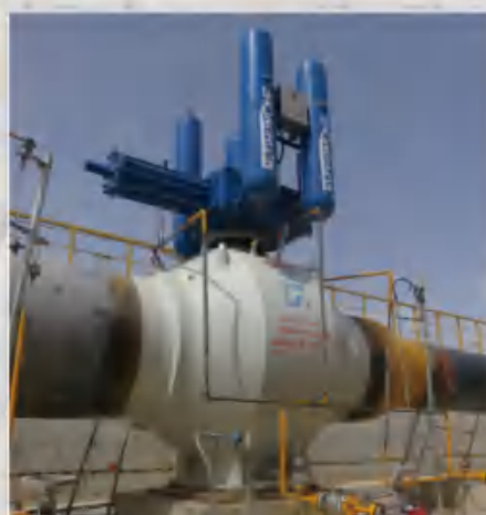
56"-900LB四阀座全焊接球阀工业性应用
