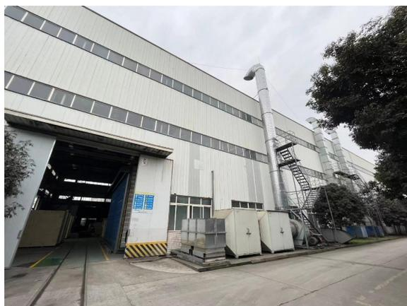
图 2-6 七车间三套有机废气处理装置及排气筒
