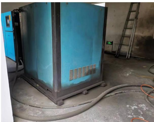
减震基础、软管
