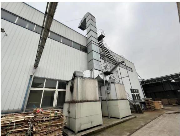
图 2-8 十车间有机废气处理装置及排气筒
