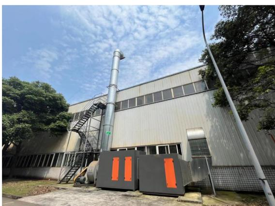
图 2-7 库房有机废气处理装置及排气筒
