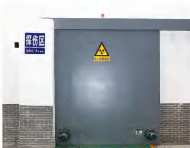
大型射线探伤室
